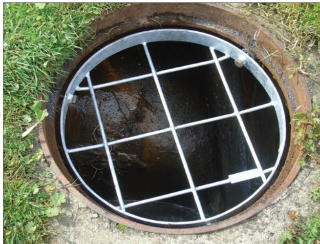
△ Caliber 安全格栅的设计旨在对现有有人孔架进行改造，以防止盖板移位时造成伤害或死亡
